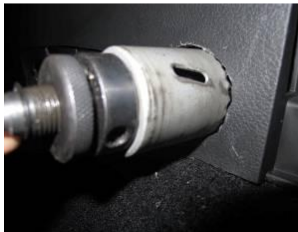
Просверлить отверстие под цилиндр замка
